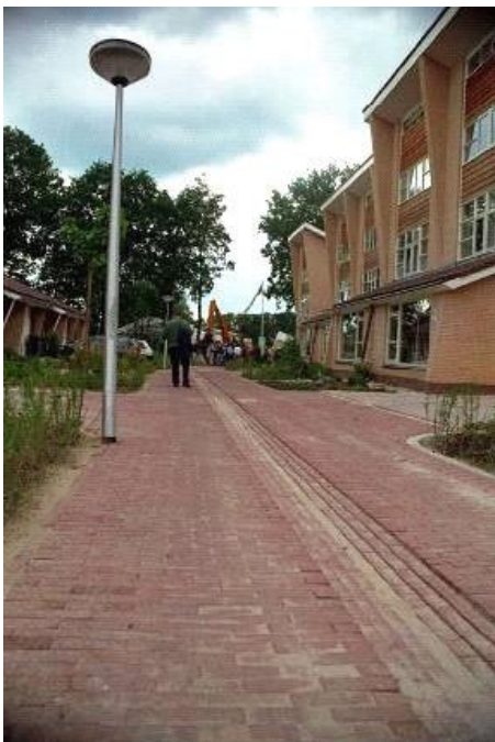
Figuur 1: Principe afvoeren hemelwater via zichtbare goot
