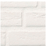
wit gekeimd metselwerk
