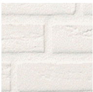
wit gekeimd metselwerk
