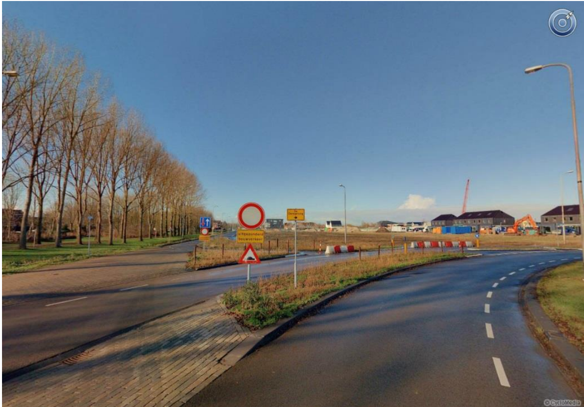
Figuur 2.3 Kruispunt Stroomzijde – Floris V Dreef februari 2015 (bron: Cyclomedia)
