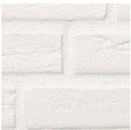
wit gekeimd metselwerk
