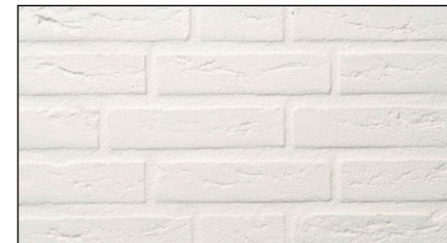
Wit gekeimd metselwerk
