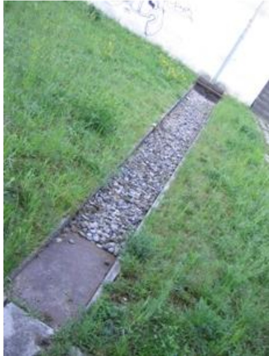
Figuur 2: Principe afvoer particulier terrein
