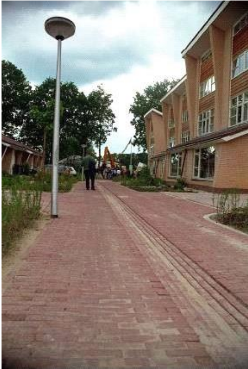
Figuur 1: Principe afvoeren hemelwater via zichtbare goot
